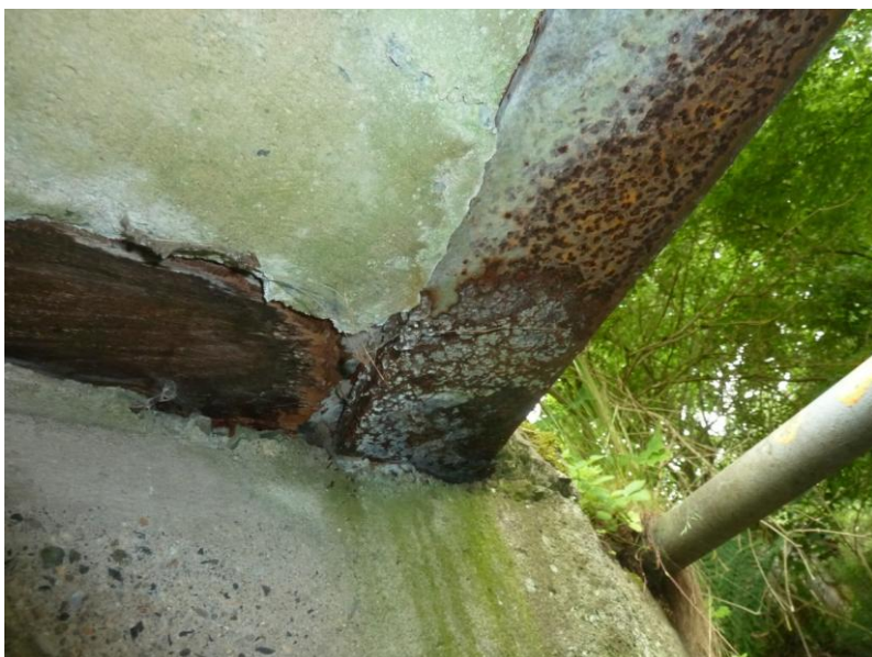
Detail ocelového nosníku v podhledu NK na vtoku v uložení
