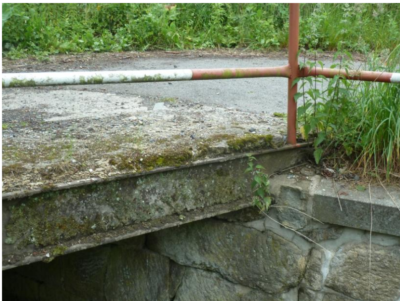
Detail ocelového nosníku na výtoku a zábradlí
