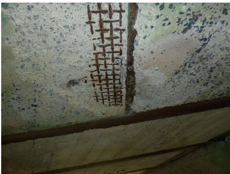
Podhled NK, obnažená korodující výztuž NK
