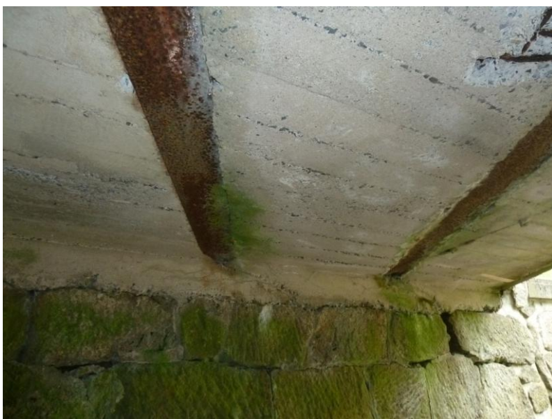
Detail ocelového nosníku v podhledu NK, stopy po zatékání
